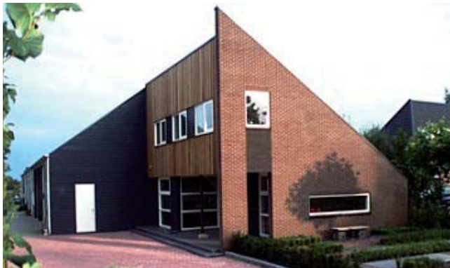
Voorbeeld van 1 bedrijfswoning met 1 bedrijfsgebouw en het kleur- en materiaalgebruik. De massaopbouw van de bedrijfswoningen en het bedrijfsgebouw zijn als eenheid ontworpen.
