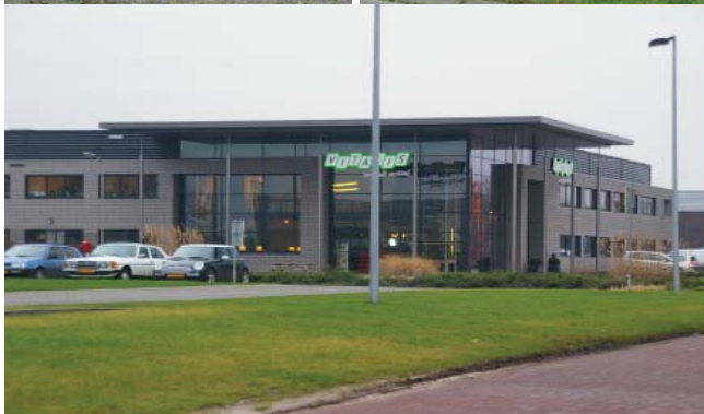
Voorbeeld representatieve architectuur en een sterke architectonische hoekoplossing.
