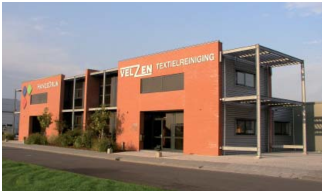
Voorbeeld representatieve architectuur en kleur- en materiaalgebruik (rode baksteen in combinatie met metallic sandwichpanelen).
